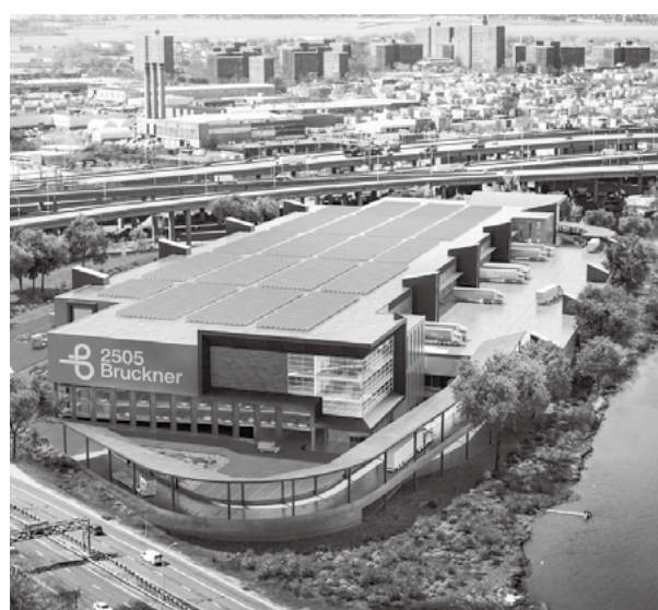
Amazonが賃貸するNY近郊のVertical Warehouse
